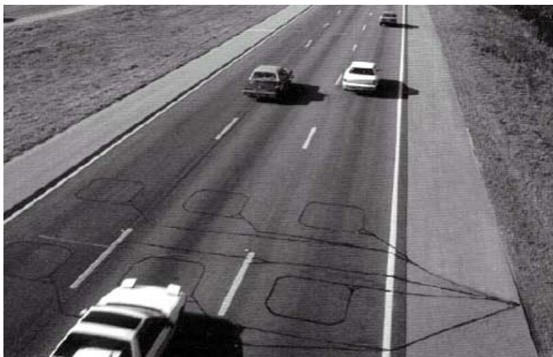
รูปที่ 4.13 เครื่องตรวจจับแบบคลื่นแม่เหล็ก (Magnetic loop detector)
